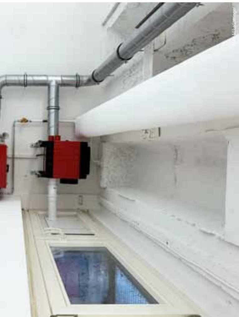
Abb. 1: Archive lassen sich mit Feuchte- und Temperatursensoren überwachen. Bei einer automatischen Steuerung kann die Raumluftfeuchte durch Sorptionstrockner reguliert werden. Wird eine solche Anlage zusätzlich mit HEPA-Filtern kombiniert, wird der Raum gleichzeitig auch von Staubansammlungen frei gehalten.
