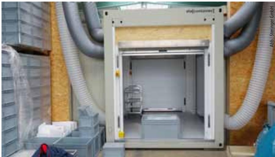
Abb. 4: Die Fundstücke werden in den geschlossenen Behältern über eine Zweikammerschleuse mit Unterdruckhaltung und Luftwechsel zu den Sicherheitswerkbanken im Reinigungsbereich transportiert.
