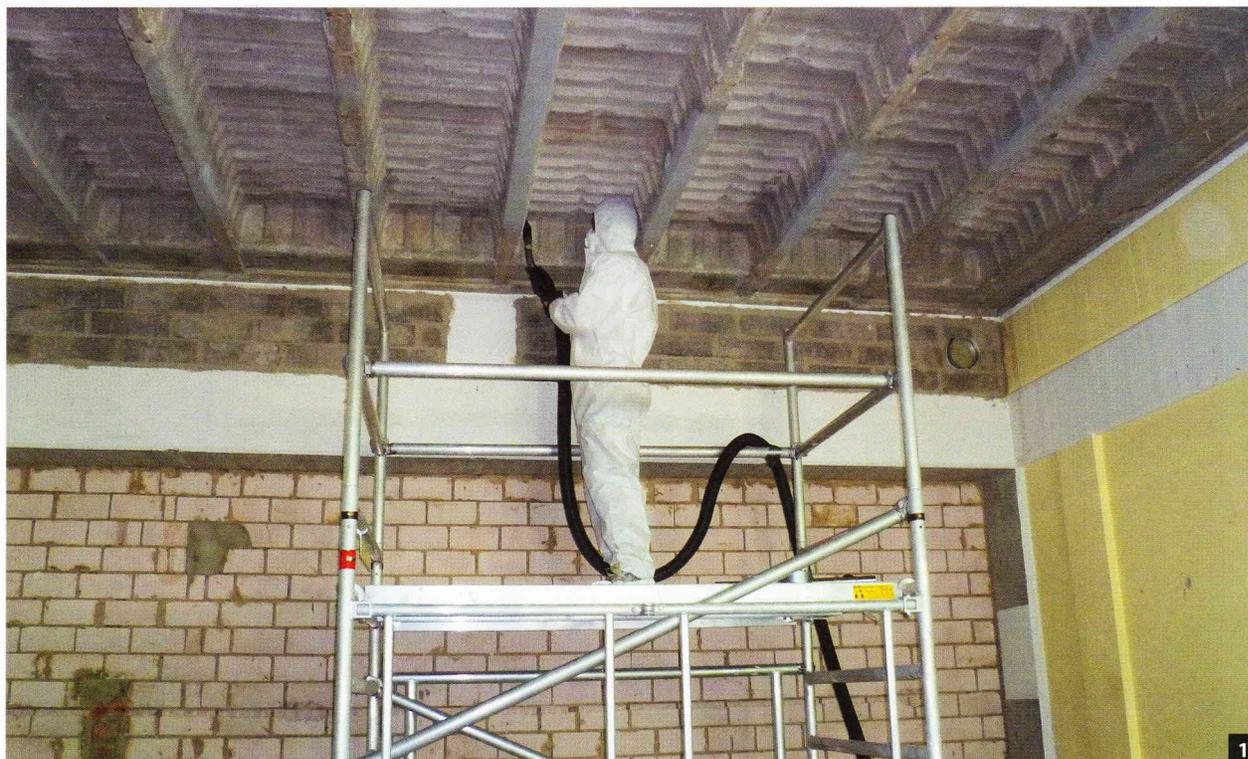
**Abb. 1:** Nachdem die mit Schimmelpilzen befallenen Verkleidungen entfernt wurden, wird die Deckenfläche einer Feinreinigung unterzogen.
